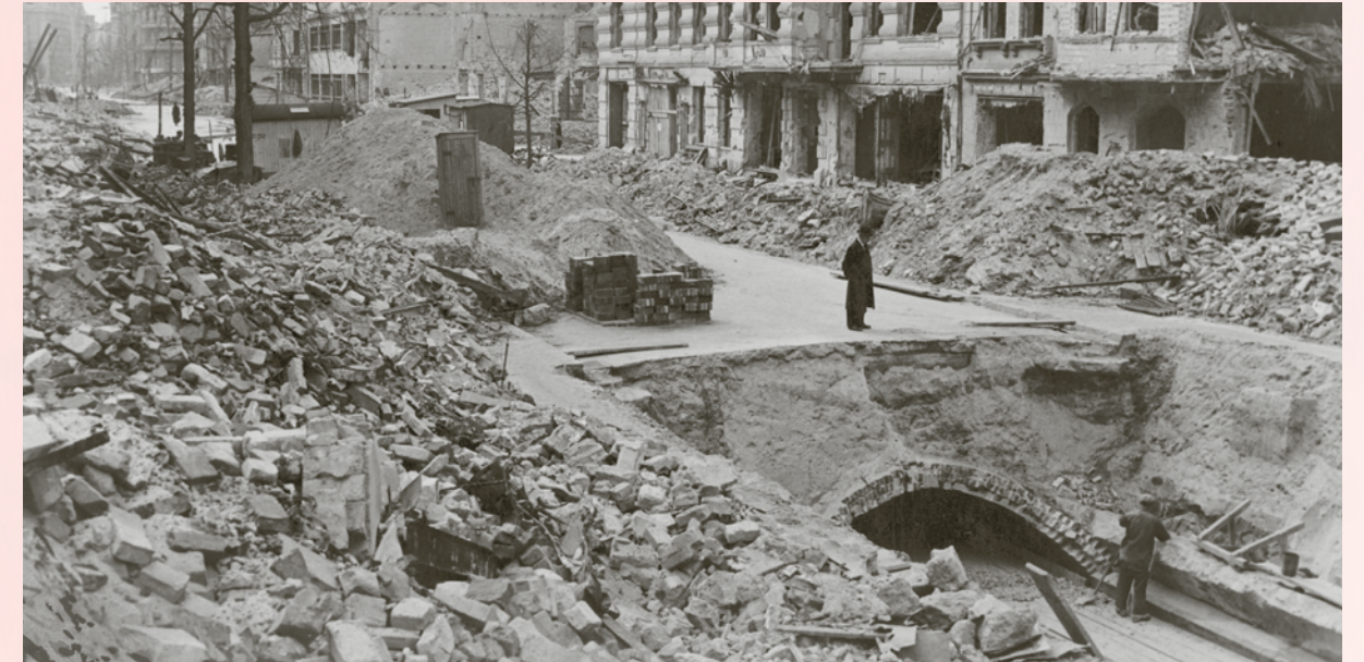
Zerstörte Kanalisation in Berlin
