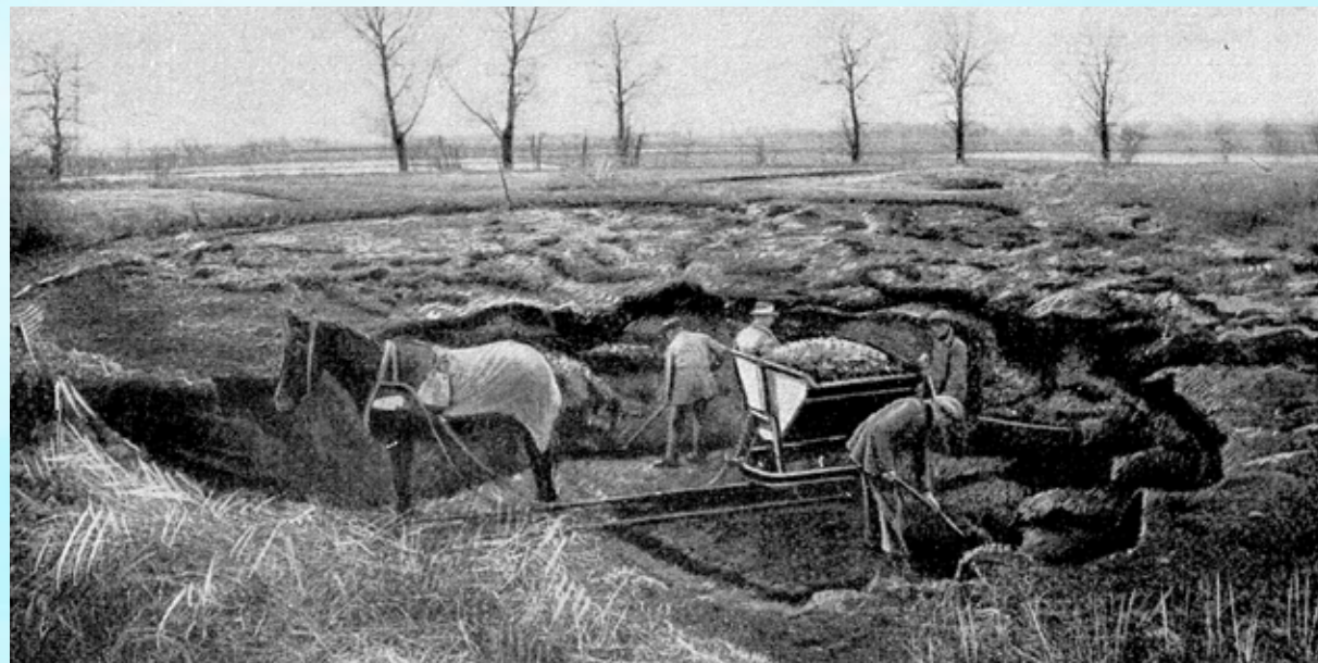
Absetzbecken auf einem Alt-Berliner Rieselfeld
